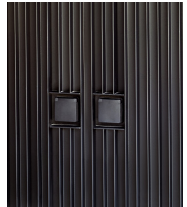
Op dezelfde manier kan je ook een stopcontact of waterkraan integreren.
